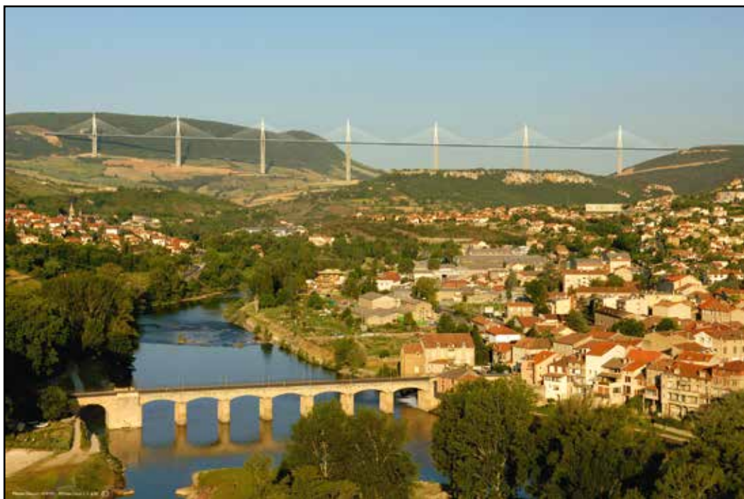
Viaduc de Millau , fin construction 2004. Photographie en couleur.
